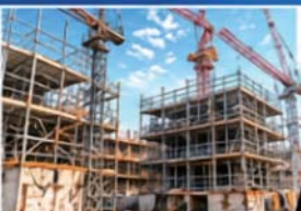
工事現場・現場作業
